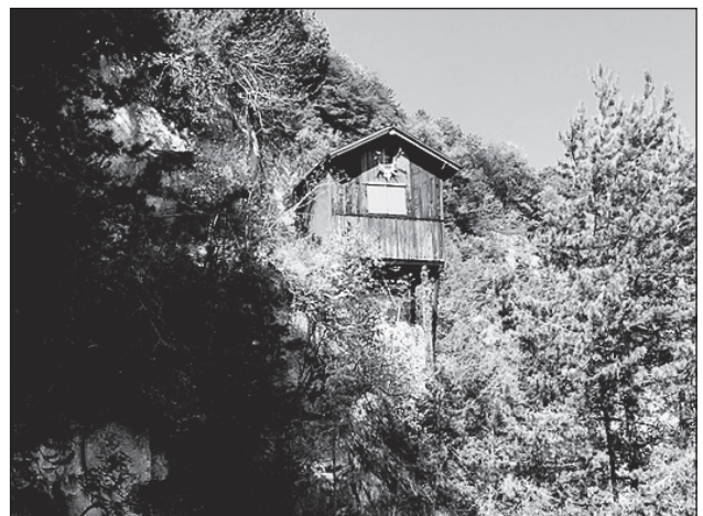
Am Abgrund: Glectsteinhütte – nur fliegen ist schöner.
